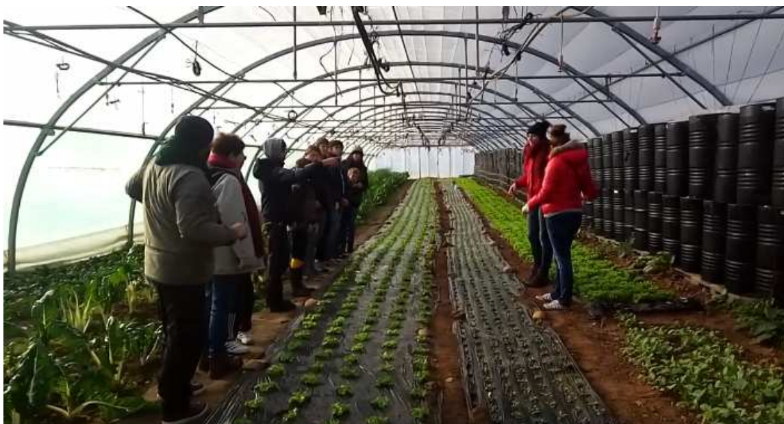
Photographie prise lors d'une visite de la « serre bioclimatique » avec son mur accumulateur de chaleur côté nord composé de fûts métalliques (à droite)
